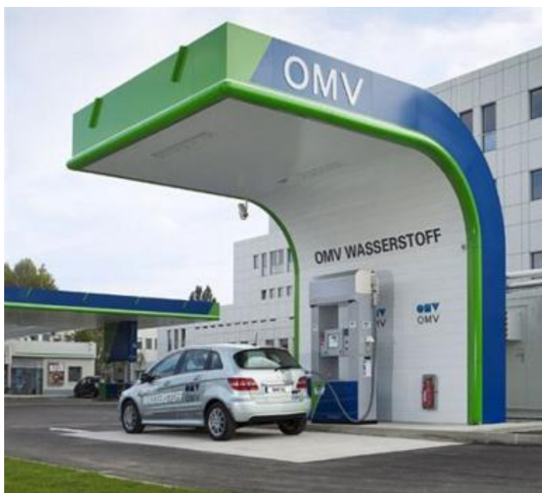
Rys. 3. Stacja tankowania wodoru na lotnisku w Stuttgarcie, z dowozem wodoru z zewnątrz i ciśnieniem tankowania 350 i 700 bar
