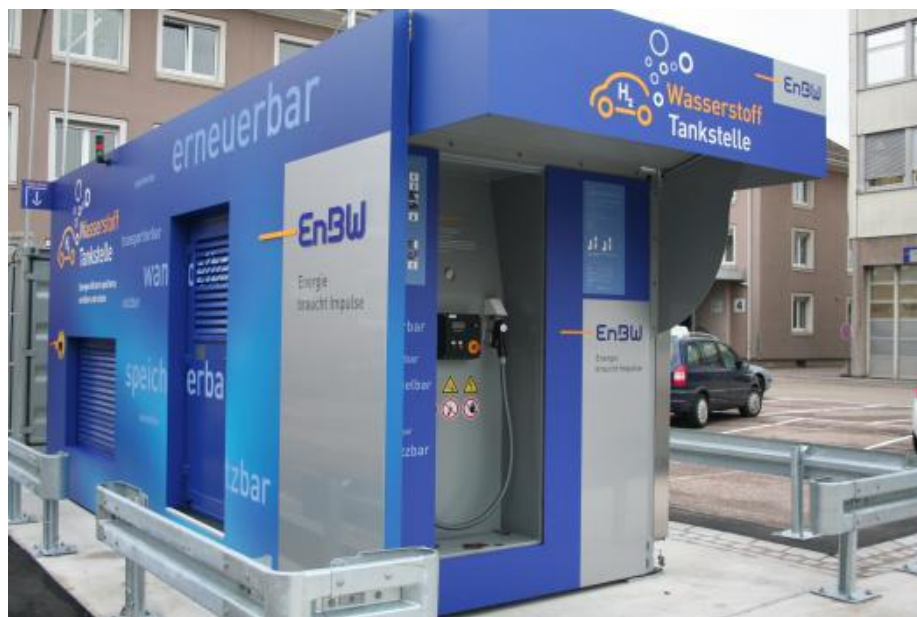
Rys. 1. Stacja tankowania wodoru w Karlsruhe z dostarczaniem wodoru z zewnątrz za pomocą rurowozu, z możliwością magazynowania 100 kg wodoru oraz ciśnieniem tankowania 350 i 700 bar [ https://www.fuelcellbuses.eu/category/demos-europe-0/ ]
