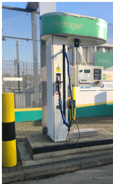
Rys. 2. Stacja ładowania wodoru w Londynie w zajezdni autobusowej przystosowana do magazynowania wodoru w ilości 180 kg i ciśnieniu tankowania 350 bar [Zbiór własny autora]
