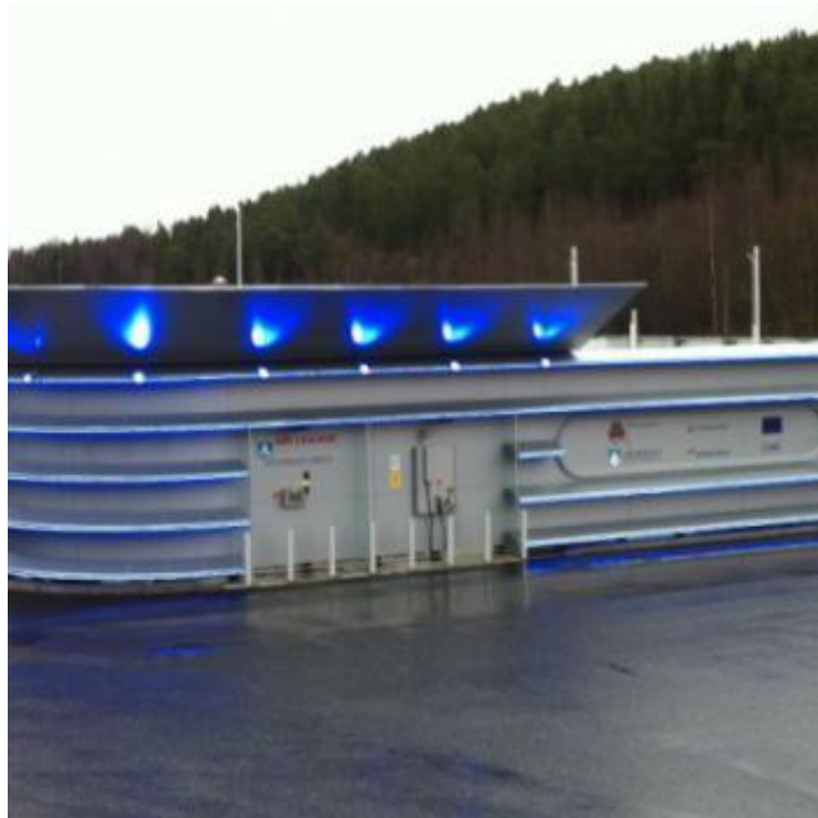
Rys. 5. Stacja tankowania wodoru z produkcją wodoru za pomocą elektrolizy wody o możliwości magazynowania wodoru w ilości 321 kg oraz ciśnieniu tankowania 350 bar [https://www.fuelcellbuses.eu/category/demos-europe-0/]
