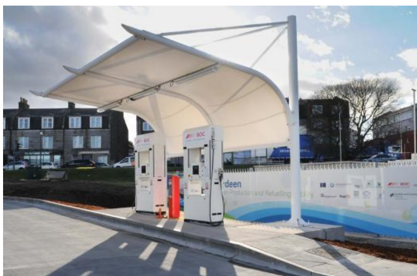
Rys. 4. Stacja tankowania wodoru z produkcją wodoru poprzez elektrolizę wody w Aberdeen z możliwością magazynowania 420 kg wodoru, i ciśnieniem tankowania 350 bar
